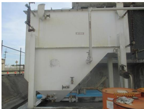
รูปที่ 5 Oil Separator
