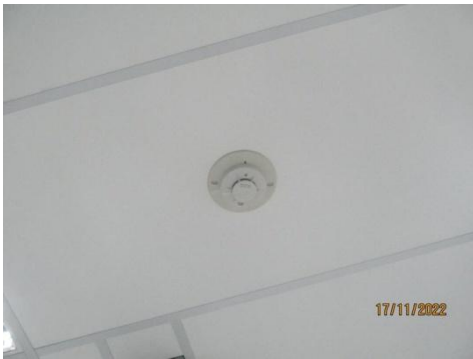
รูปที่ 20 Smoke Detector
