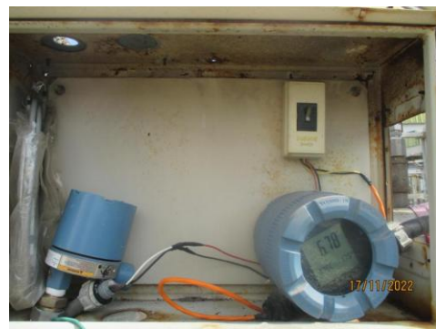
รูปที่ 6 pH Meter Online ที่บ่อปรับสภาพ ความเป็นกรด-ด่าง
